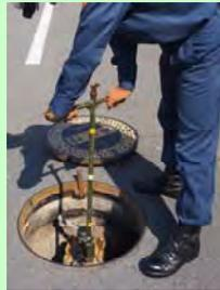
消火栓のカギを時計回りに少しずつ回し、使用可否を確認し(訓練時は汚れた水が、きれいな水になったら)止める
