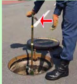
スピンドルが硬くて回らない時は、両手で強く回すのではなく、片手の手のひらでハンドル部分を叩くようにして、カギが急激に回らないようにする
