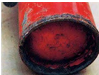
錆や塗装の剥離
