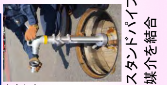
スタンドパイプの支持レバーを上にも強く引っ張り張り結合の確認
